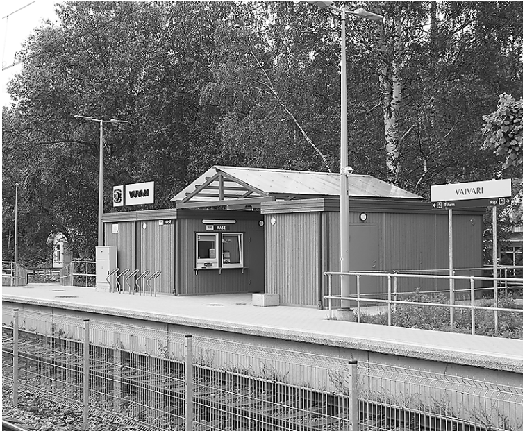
Vaivaru stacija pēc rekonstrukcijas: konteineri, savienoti ar jumtiņu.
