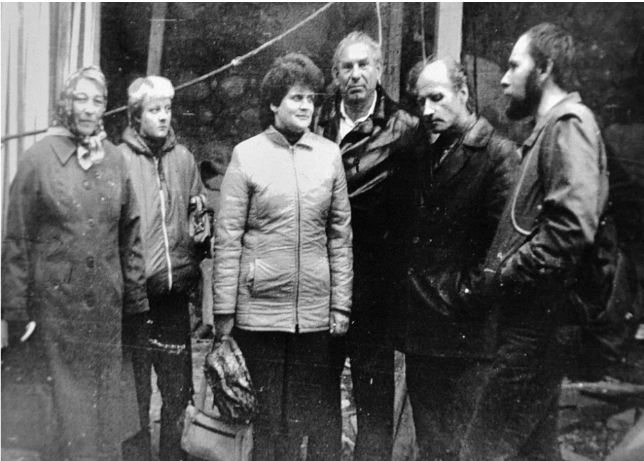
1985. gada 18. septembrī zem tikko uzslīetās jumta daļas no kr.: bijusī Rūjienas izpilddomitejas pr-tāja Ilga Lenša, kuras laikā iesākās jumta būvniecība, Ingrīda Kukaine, izpilddomitejas pr-tāja Alma Zālīte, kas turpināja I. Lenšas iesāktu un atbalstīja baznīcas atjaunošanu, būvbrigādes vadītājs Harijs Čākurs, kolhoza «Straume» pr-tājs Jānis Dukurs un mākslas vēsturnieks Jānis Kalnačs.
